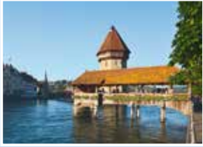
Kappelbrücke, Kanton Luzern
